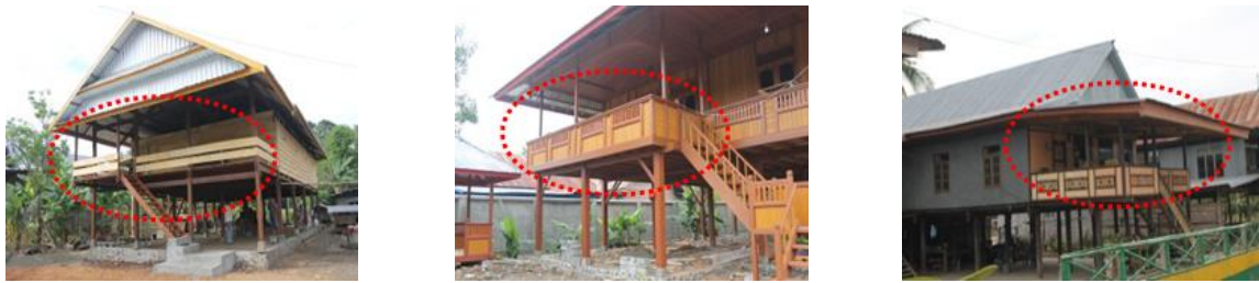
Gambar 3. Prototype Lego-lego pada rumah panggung Bugis Sumber : Hasil survey penulis, 2017
